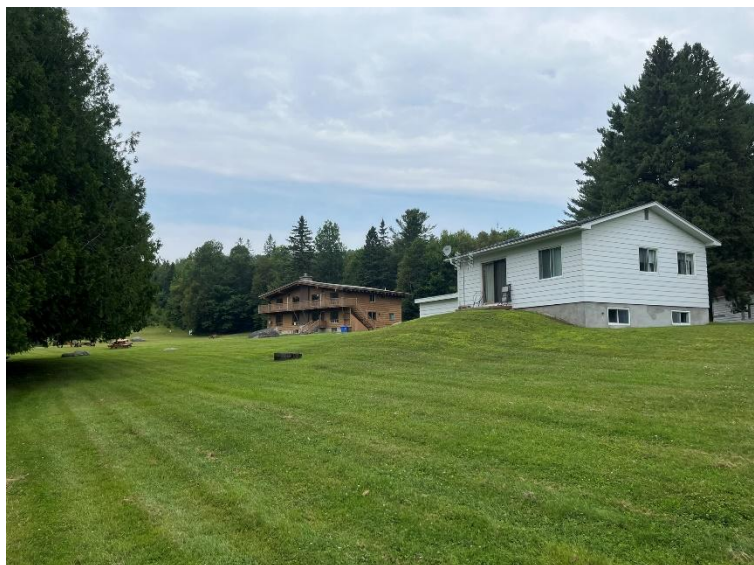
Parc Castel-Marie, vue générale de quelques bâtiments.
