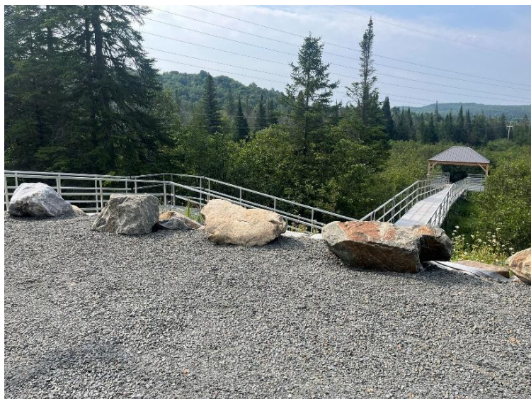
Halte- municipale, vue du stationnement.
