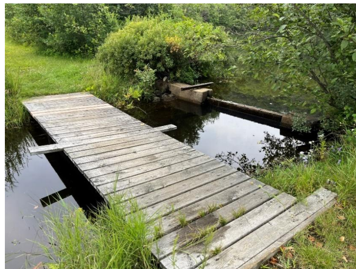
Parc Castel-Marie, pont de bois dans le secteur de l'étang 4.
