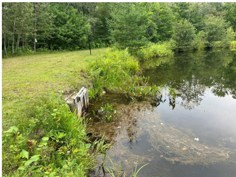
Parc Castel-Marie, ouvrage de retenue, secteur de l'étang 2.
