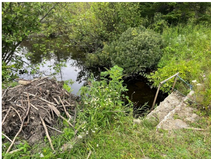
Parc Castel-Marie, ouvrage de retenue dans le secteur de l'étang 4.
