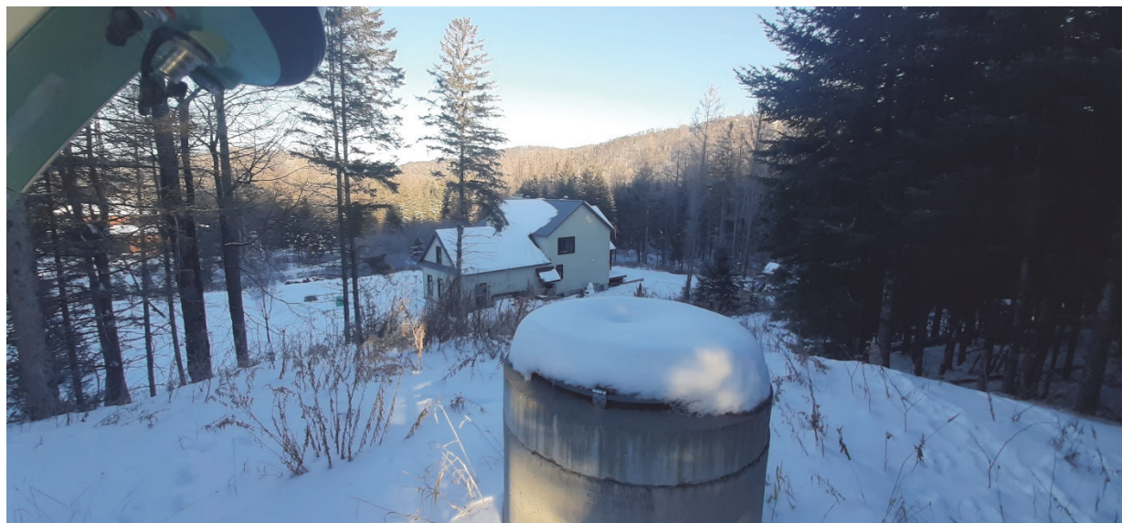
Photo 1 : Aperçu du regard en béton à l'intérieur duquel se trouve le puits No 1 – 2021-01-08
