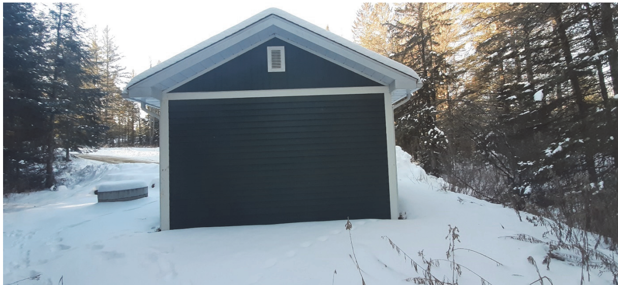
Photo 2 : Aperçu du regard en béton à l'intérieur duquel se trouve le puits No 2 - 2021-01-08
