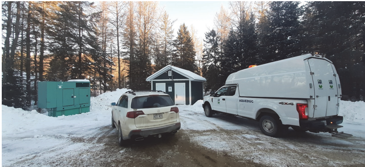
Photo 3 : Aperçu du bâtiment de production d'eau potable – 2021-01-08
